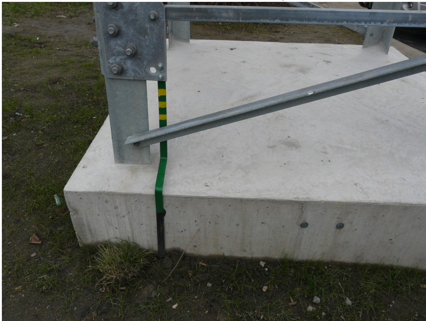
Obr. č.1 – Provedení uzemnění a nátěru
